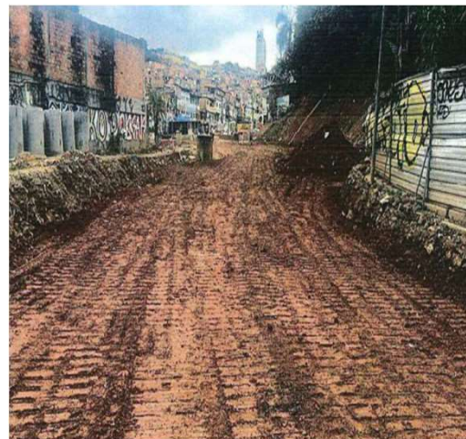
Realização Regularização da Greide da Projetada 01 - Foto: mar./24.
