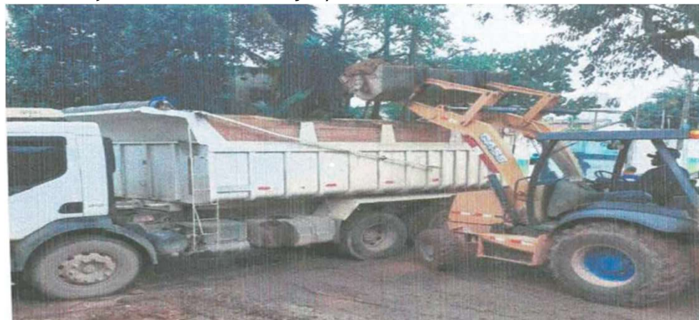
Carga de Material destinado para Botafora – Foto: fev./24.
