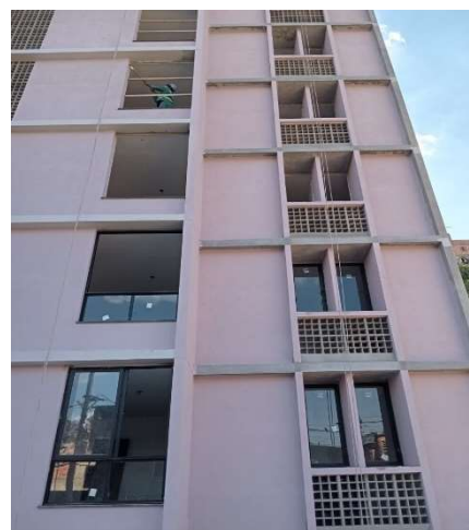
Execução de fachada da provisão. Abril/2024.
