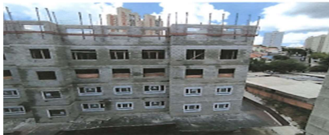
Alvenaria – Domênico Martinelli. Foto: fev./24.
