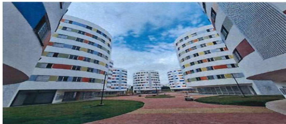
Condomínio 5 - Instalação dos Brises- Foto: mar./24.
