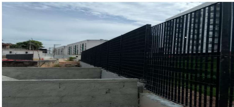
Execução de Gradil - Foto: fev./24.
