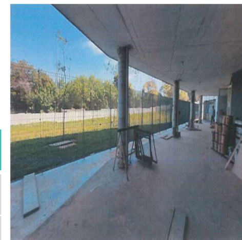
Gradil da Área da App e Calçada de Concreto do Perímetro do Prédio – Foto: mar./24.
