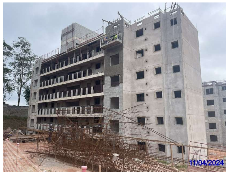
Obras de provisão. Vila do Sol. Abril/2024.
