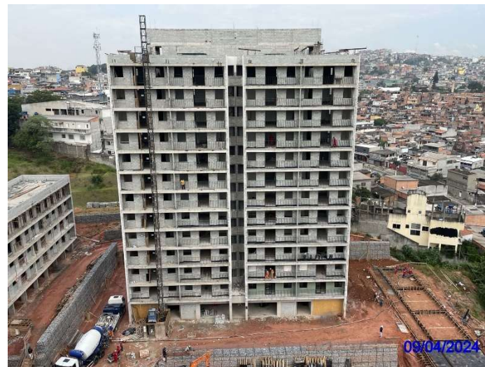
Execução da provisão – Vila Nordestina. Abril/2024
