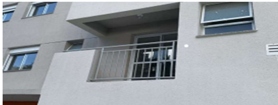
Guarda Corpo + Corrimão das Sacadas – Foto: mar./24.
