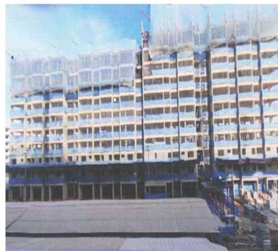
Execução de Estrutura 14º Pavimento – Torre 4 - Foto: mar./24.
