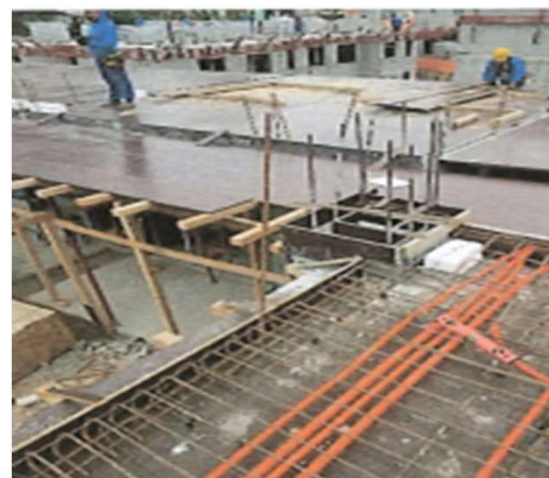
Eletródutos, Forma e Armação – Domênico Martinelli. Foto: fev./24.
