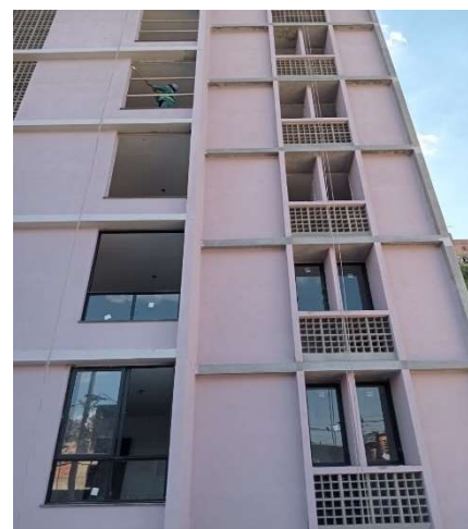
Execução de fachada da provisão. Abril/2024.
