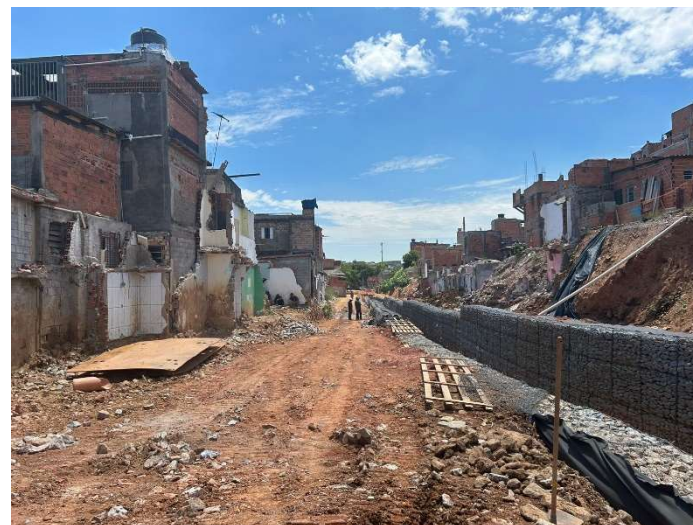
Canalização de córrego. Jardim Ângela. Jan/2024.
