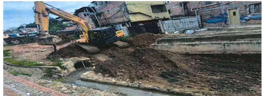
Realização da Escavação para Desassoreamento do Córrego no Trecho 1 da Obra - Foto: mar./24.
