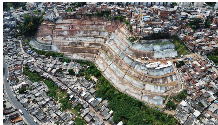
Morro dos Macacos. Contenção. Abril/24
