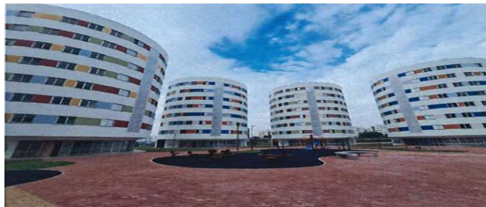
Condomínio 5 - Instalação dos Brises- Foto: mar./24.
