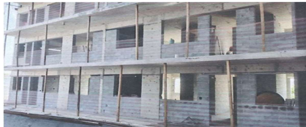
Cond. A – Alvenarias do 2º e 3º Pavimento - Foto: nov./23.
