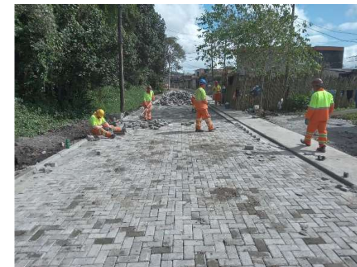
Vargem Grande. Viário. Abril/2024.
