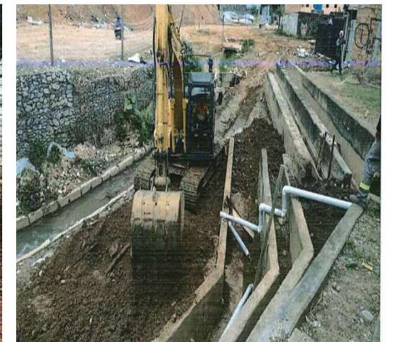
Realização da Escavação para Desassoreamento do Córrego no Trecho 1 da Obra – Foto: marc./2024.
