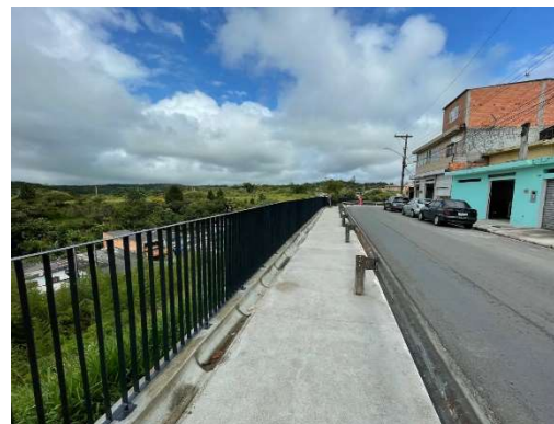
Jardim Santa Terezinha. Calçada, guarda-corpo e contenção. Março/2024.
