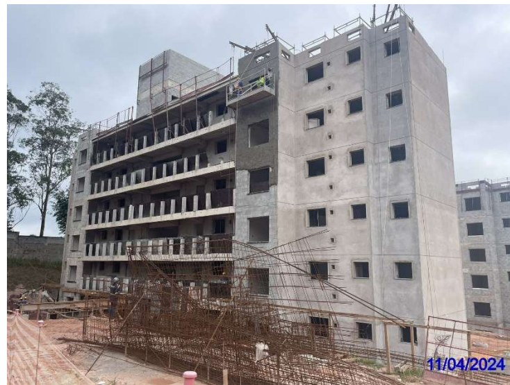
Obras de provisão. Vila do Sol. Abril/2024.
