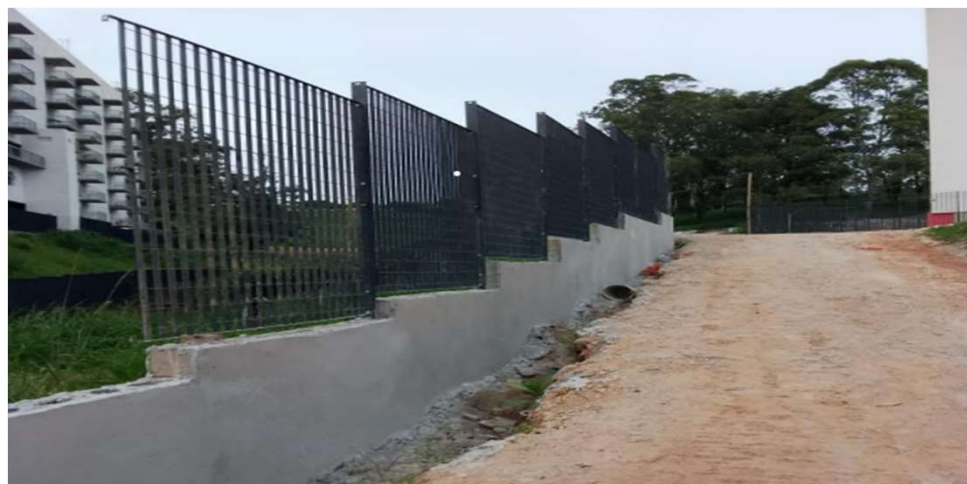
Execução de Gradil - Foto: fev./24.
