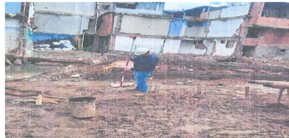
Fase 3 – Marcação das Estacas (Topografia) – Foto: : mar./24.
