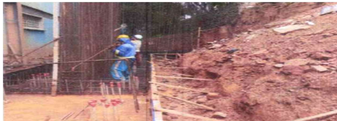
Adequação em Torno da Obra – Foto: fev./24.
