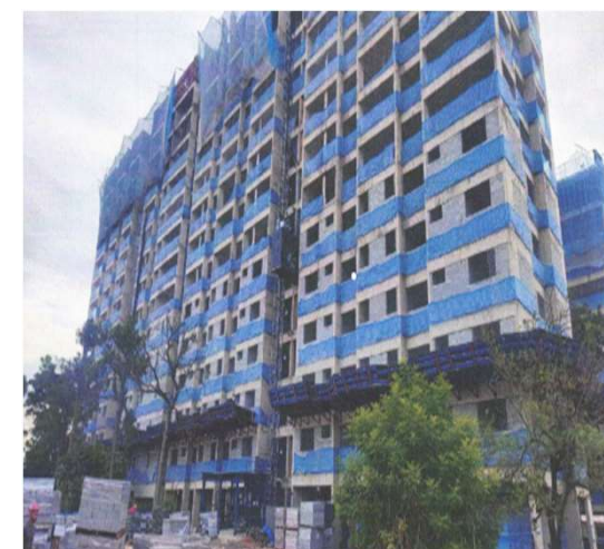
Execução de Estrutura 14º Pavimento – Torre 5 - Foto: mar./24.
