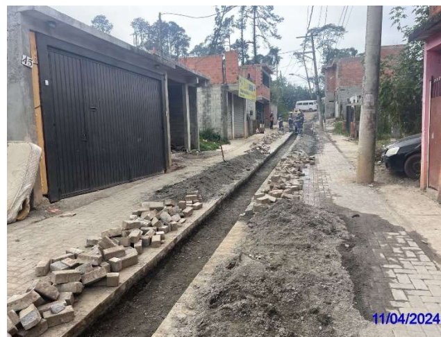
Obras de drenagem. Chácara Flórida. Abril/24.
