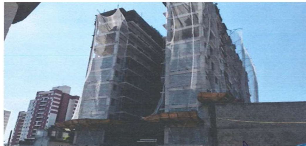
Cond. A – Alvenaria/ Estrutura/Fôrma e Cimbramento- Foto: nov./23.
