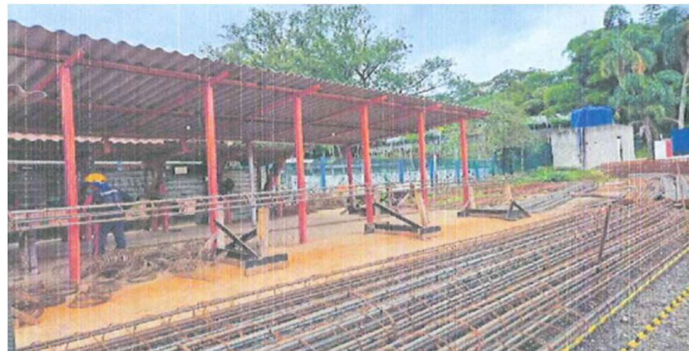
Canteiro – Armação das Estacas - Foto: mar./24.
