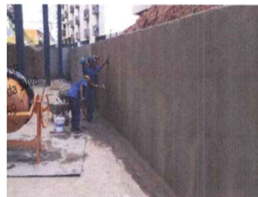
Eq. do Canteiro- Infraestrutura - Foto: fev./23
