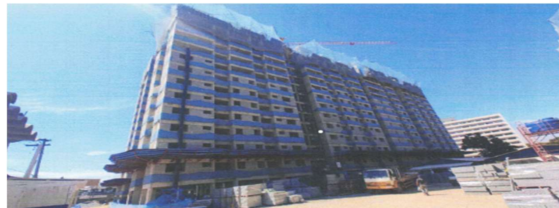
Execução de Estrutura 14º Pavimento – Torre 3 – Foto: mar./24.
