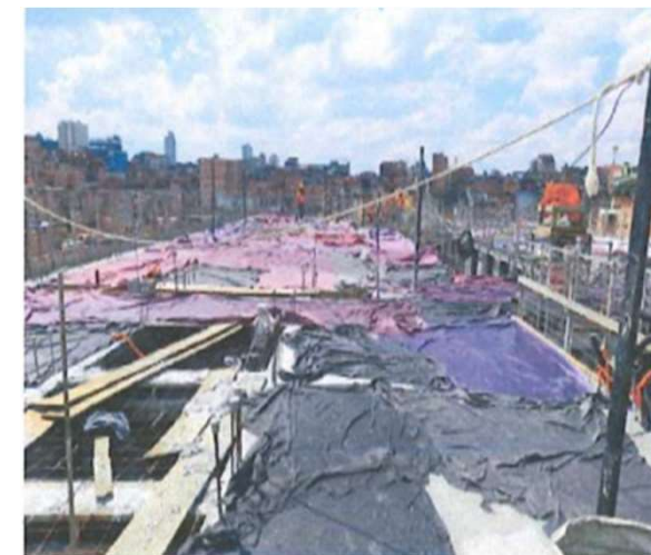
Laje Concretada em Cura - Foto: mar./24.
